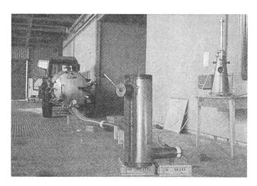
Abb. 4: Messung der geförderten Luftmenge beim Ansaugen. Vom Fass wird über eine Messleitung mit Venturi-Düse und Drosseleinrichtung Luft angesogen. Durch die Druckdifferenz lässt sich das durchströmende Luftvolumen errechnen.
