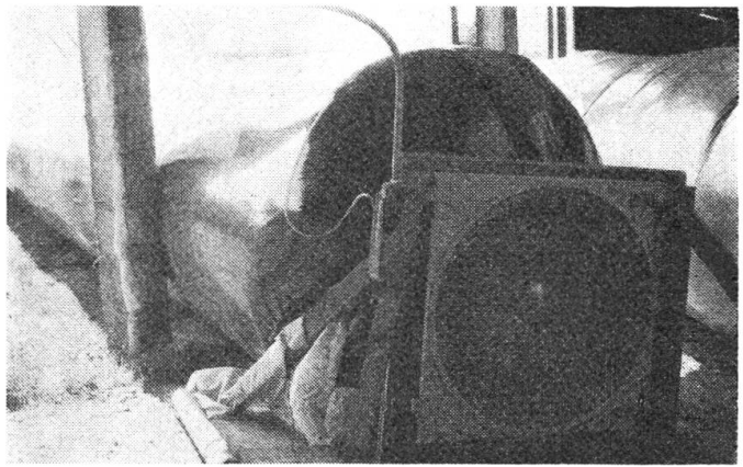
Abb. 7: Dieser von der Wand entfernte Axial-Ventilator wird mittels Holzlatten auf einem Bretterboden fixiert.
