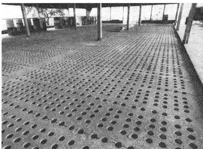
In Größen von 2–3 m Länge und in Breiten von 0,55 m werden die Beton-Lochböden angeboten. Die regelmässig angeordneten Löcher machen 20% der Lauffläche aus.
