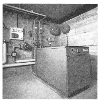
Abb. 3: Hoval-Wärmepumpe WW-Automat ohne Wassererwärmer für die Wärmenutzung aus Wasser sowie Erd- und Sonnenkollektoren, Leistungsbereich 19–46 kW.
