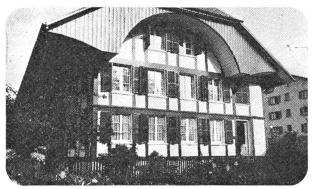
**Bildlegende:** HEGLAS-Isolierglas mit Sprossen, damit das charakteristische Aussehen erhaltenswerter Fassaden bestehen bleibt.
