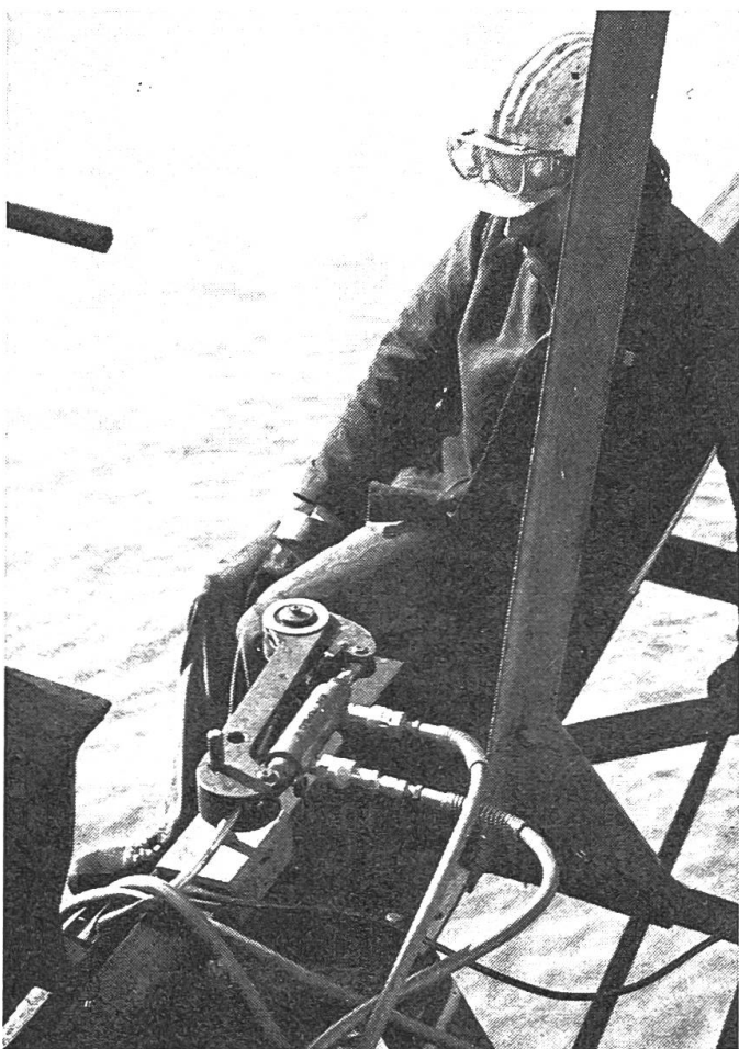
Die Nieten werden in 35 m Höhe mit einem ENERPAC Verschraubungsgerät durch Muttern und Bolzen ersetzt.
