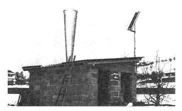
Abb. 3: Die fertig montierte Hagelschutz-Kanone.
