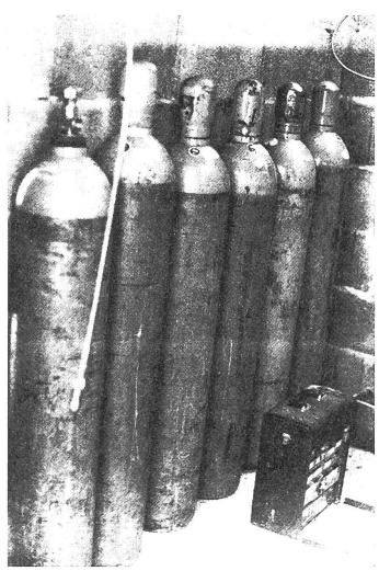
Abb. 5: Eine Batterie von Azetylenflaschen.
