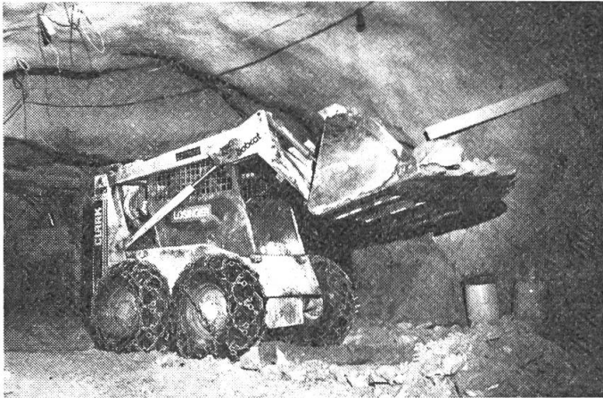
Abb. 1: Aufnahme des ausgebrochenen Eis- und Felsmaterials im neuen Zugangsstollen der PTT-Station.
