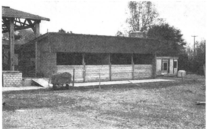
Abb. 4: Nach Süden ist der Offenfrontstall offen. Durch Entfernen der Bretter können die Buchten mit dem Frontlader gemistet werden.
