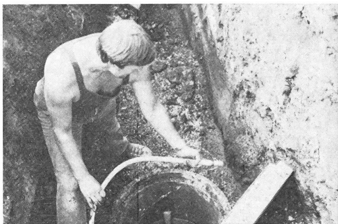
Abb. 1: Spülkopf, der in die Röhren vorgetrieben wird.
