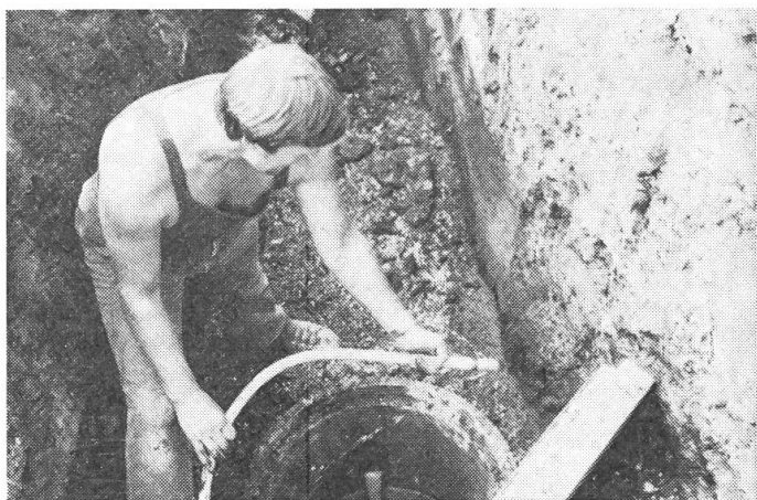
Abb. 1: Spülkopf, der in die Röhren vorgetrieben wird.
