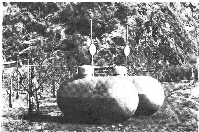
Abb. 6: Lagertanks für Flüssiggas.
