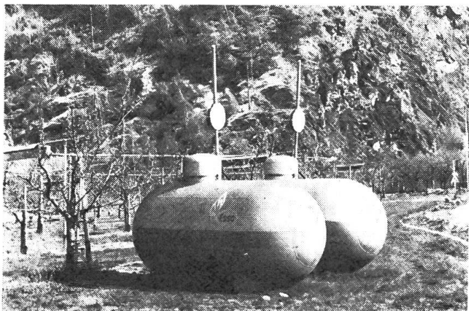
Abb. 6: Lagertanks für Flüssiggas.
