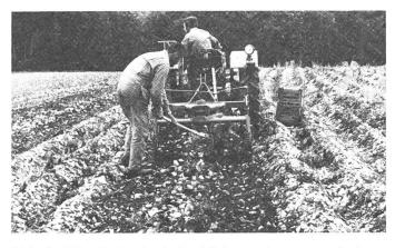
Abb. 6: Die Ernte in Lehmböden mit extrem hohem Steinbesatz muss infolge grosser Störungsanfälligkeit der Vollernter und hohen Knollenbeschädigungen meistens mit dem arbeitsaufwendigen Vorratsrodeverfahren vorgenommen werden.
