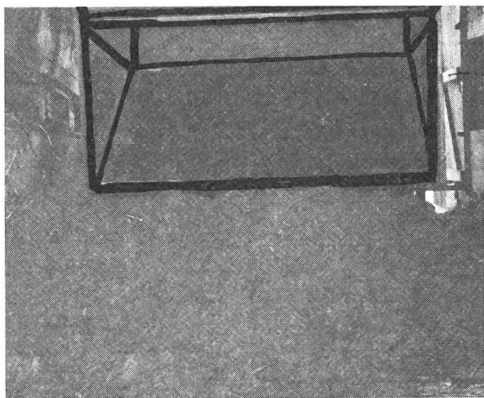
Auf Bild Nr. 2 ist der schräg angebrachte Boden sichtbar. Mit wenig Handarbeit rutscht das Silomais auf den Tennboden und der Bunker kann wieder auf seinen Abstellplatz versorgt werden.
