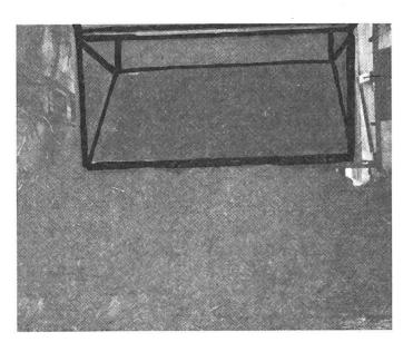
Auf Bild Nr. 2 ist der schräg angebrachte Boden sichtbar. Mit wenig Handarbeit rutscht das Silomais auf den Tennboden und der Bunker kann wieder auf seinen Abstellplatz versorgt werden.
