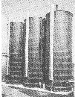
Der neue Andermatt-Silo im Freien zeichnet sich durch mannigfache Vorteile aus: Problemloser Transport schnelle Montage Druckimprägniert @ Gasdicht aus 50 mm Schweden-Föhrenholz gebaut Alle Rundeisenbindungen, Beschläge, Abwurfschacht und Dachgeländer verzinkt Fugen 3fach genutet @ doppelter Federzug fertig eingeteert Naturfreundlich
