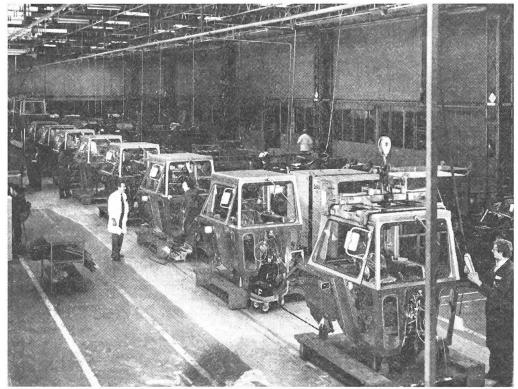
Abb. 4: Die im Werk Marquettelez-Lille vorgefertigten Integralkabinen werden hier montagefertig ausgerüstet.
