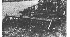
mit NEUER Spatenwalze für pfluglosen Ackerbau Arbeitstiefe: starre Zinken bis 55 cm abgefederte Zinken 30cm
