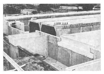
Abb. 8: Einbau des Spaltenbodens.
