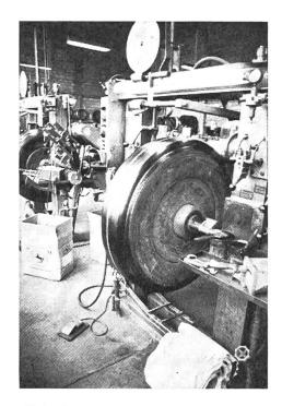
Abb. 2: Blick in ein modernst ausgerüstetes Neugummierungswerk. Das Profil wird in einem weiteren Arbeitsgang mithilfe einer geheizten Form in die aufvulkanisierte Lauffläche gedrückt.
