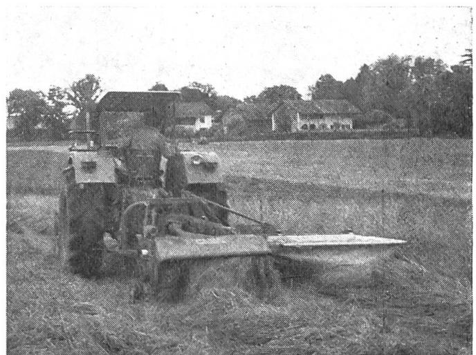
beträgt 1,65 m. Flächenleistung bis 2 ha/h (je nach Bodenverhältnissen). Nicht zuletzt der guten FAT-Testergebnisse und des günstigen Preises wegen ist diese universelle Maschine in der Schweiz nach kurzer Zeit zu einem Schlager unter den Aufbereitungsmaschinen geworden. Verkauf und Service für die Schweiz:
