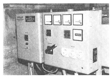
Abb. 3: An Aggregat angebauter Steuerkasten mit Anzeigeinstrumenten und Hauptschalter.
