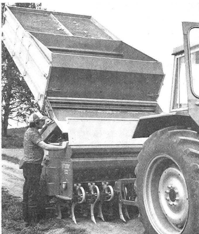
tels der Sperrschieber des Auslaufblechs wird die gewünschte Menge von Aussaat und Dünger in die Behälter der Maschine abgefüllt. Die Getreidekassette und das Auslaufblech sind leicht trennbar. Dies ermöglicht die Anwendung des Wagens als einen gewöhnlichen Anhänger.
