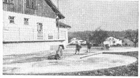
Güllebehälter bis zu 4 m Höhe werden in einem Guss hergestellt, keine Arbeitsfugen, daher maximale Sicherheit!
