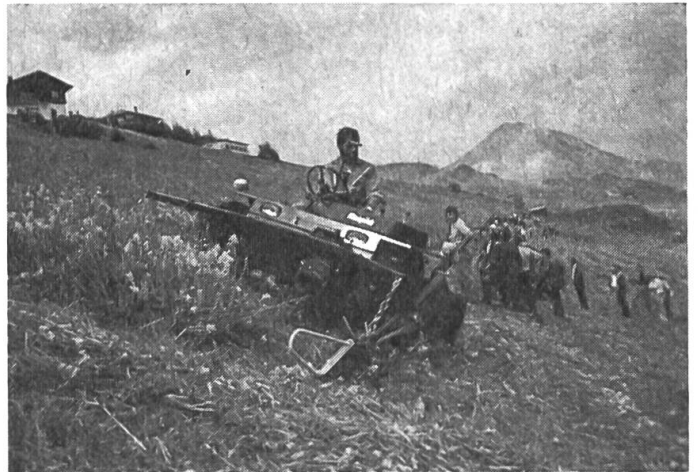
Rapid Heureka, 22 PS, mit Busatis-Doppelmesser-Frontmähwerk, 2 m Schnittbreite.
