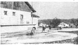
Güllebehälter bis zu 4 m Höhe werden in einem Guss hergestellt, keine Arbeitsfugen, daher maximale Sicherheit!
