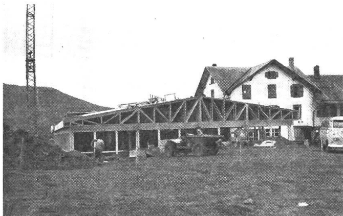
Abb. 2: Nahansicht des Rohbaues. Man beachte das ungewohnte Ausmass der Verstreubungen.
