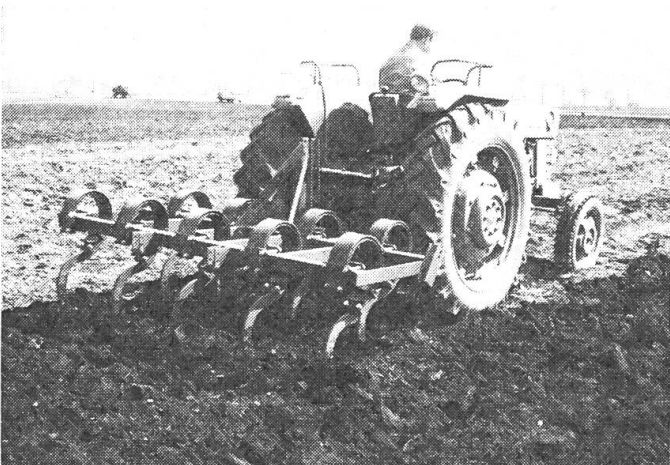
Abb. 4 + 5: Für die Stoppel-Bearbeitung (Arbeitstiefe 15 bis 20 cm) sind alle Grubberarten und somit auch jene mit halbstarren Zinken geeignet.
