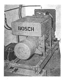
Abb. 4: Diese Anlage leistet 30 kVA und wird von einem 2-Zylinder-30-PS-Dieselmotor betrieben. Bei Stromausfall startet sie automatisch. Die wichtigsten Apparaturen können an diese Automatik angeschlossen werden.
