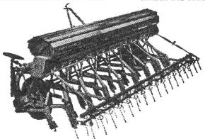
in Breiten von 2-6 m mit beidseitigem Antrieb, zentraler Druckregulierung, hohe Scharen usw.
