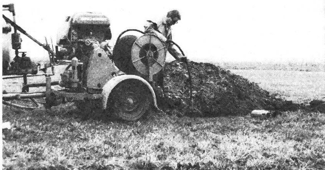
Abb. 4: Spülung eines Saugers vom aufgegrabenen Anschluss her.
