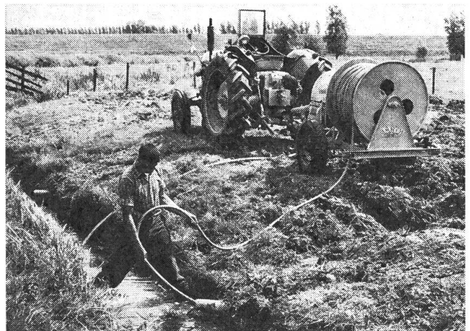
Abb. 3 Spülung eines Saugers von der Grabenausmündung her.
