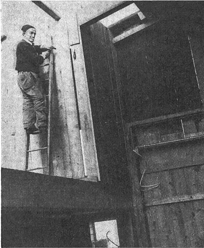
Abb. 1 zeigt einen Ausbau des Estrichzimmers zwischen Schweinestall und Decke mit schönem, einheimischen Holz.
