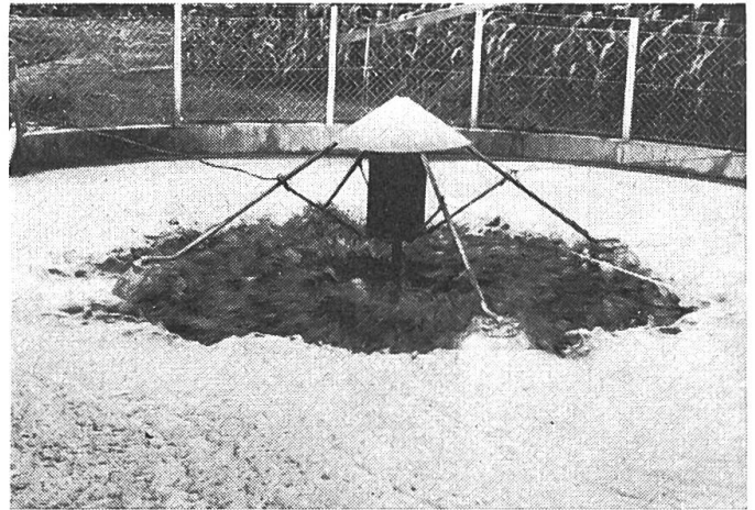
Abb. 2: Oberflächenkreisel mit Schwimmgerüst.
