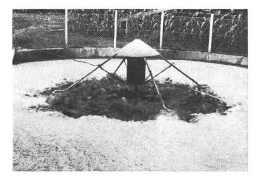
Abb. 2: Oberflächenkreisel mit Schwimmgerüst.
