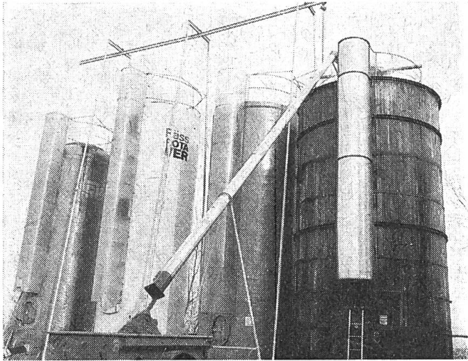
Abb. 4: Kranbahn über vier Silos. Anschaffungskosten inkl. Obenentnahmefräse Fr. 16 000.—.
