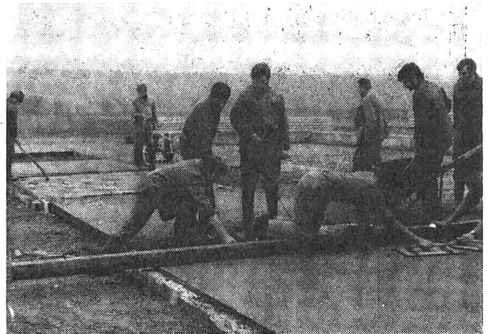
Abb. 3: Betonieren der Durchfahrt bei einer Scheune vor dem Aufrichten. (Foto: Dr. Kohler, Ins)
