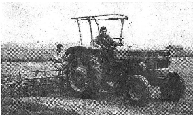
Getriebe: 12 Vorwärtsgänge ni 3 Stufen, 4 Rückwärtsgänge, alle Gänge vollsynchromisiert, Lenkradschaltung.
