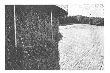
Abb. 5: Aufstehen der Schürze beim Senken des Daches.
