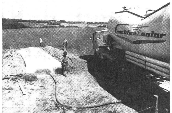
Abb. 1: Aus dem Silozug staubfrei direkt in die Kunststoffhülle — die Befüllung dauert nicht länger als bei einem normalen Düngersilo. Dieses Verfahren ermöglicht eine preiswerte Zwischenlagerung von Düngemitteln im landwirtschaftlichen Betrieb, die ausserdem sehr variabel ist.
