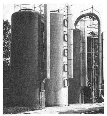
Abb. 8: Gärfutterwinkel (v.l.n.r.): Rovingwickel-, Schleuder- und Bandwickelverfahren
