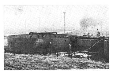
Abb. 10: GFK-Behälter zur Belüftung von Abwässern
