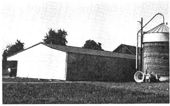
Abb. 3: Stahlrohrhalle, mit Folien verkleidet
