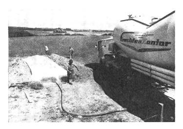
Abb. 1: Aus dem Silozug staubfrei direkt in die Kunststoffhülle – die Befüllung dauert nicht länger als bei einem normalen Düngersilo. Dieses Verfahren ermöglicht eine preiswerte Zwischenlagerung von Düngemitteln im landwirtschaftlichen Betrieb, die ausserdem sehr variabel ist.
