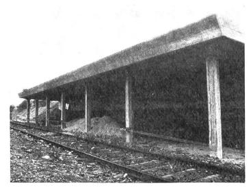
Abb. 7: Hochrampe mit Betonsäulen an einer Böschung.
