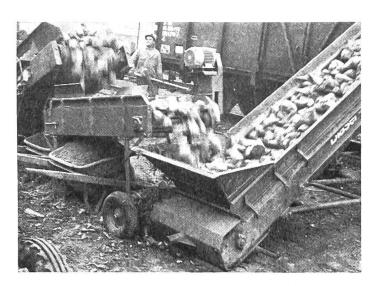
Abb. 2: Förderbandanlage mit Erdabscheider.
