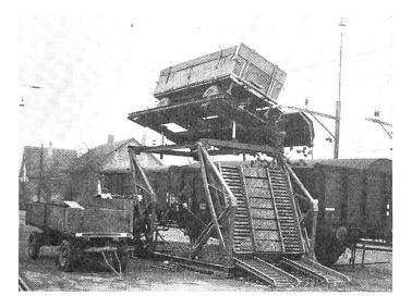
Abb. 3: Stationäre vollhydraulische Hochkipprampe.
