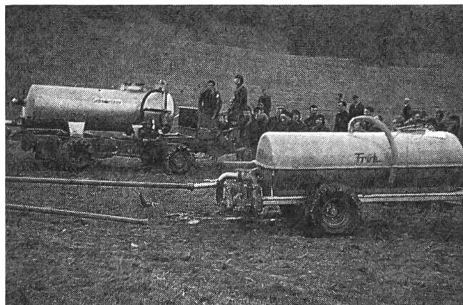
Links: Aufbau-Pumpfass (2000 lt) auf einem Selbstfahrladewagen (40 PS), demontiertem Pick-up und Ladebrücke.
