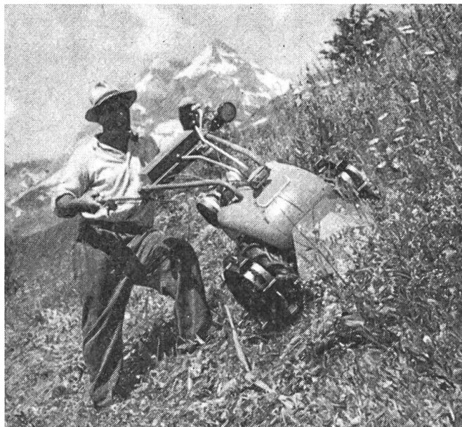
Abb. 2: Ein Mäher der mittleren Gewichtsklasse, dessen Ausrüstung bereits so ist, dass damit schon beachtliche Flächenleistungen zu erzielen sind.
