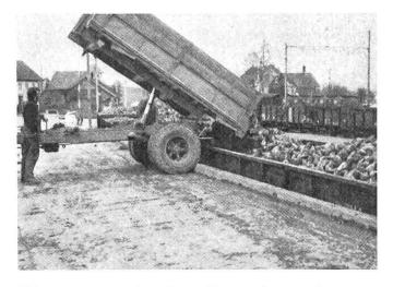
Abb. 7: Eine Hochauffahrt-Rampe bietet eine gute Ablademöglichkeit für Kipper und Wagen mit Kratz- oder Rollboden.
