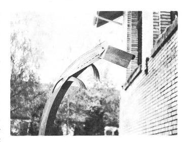
Abb. 2: Auswurfrohr mit zwei Lischenabscheider.
