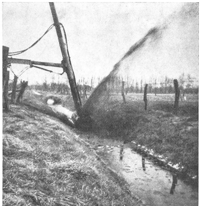
Grabenräumgerät «Grabenfrei-Neu» als Anhängergerät im Einsatz. (Werkfoto: Fa. J. v. Davier KG, Wellinghausen)
