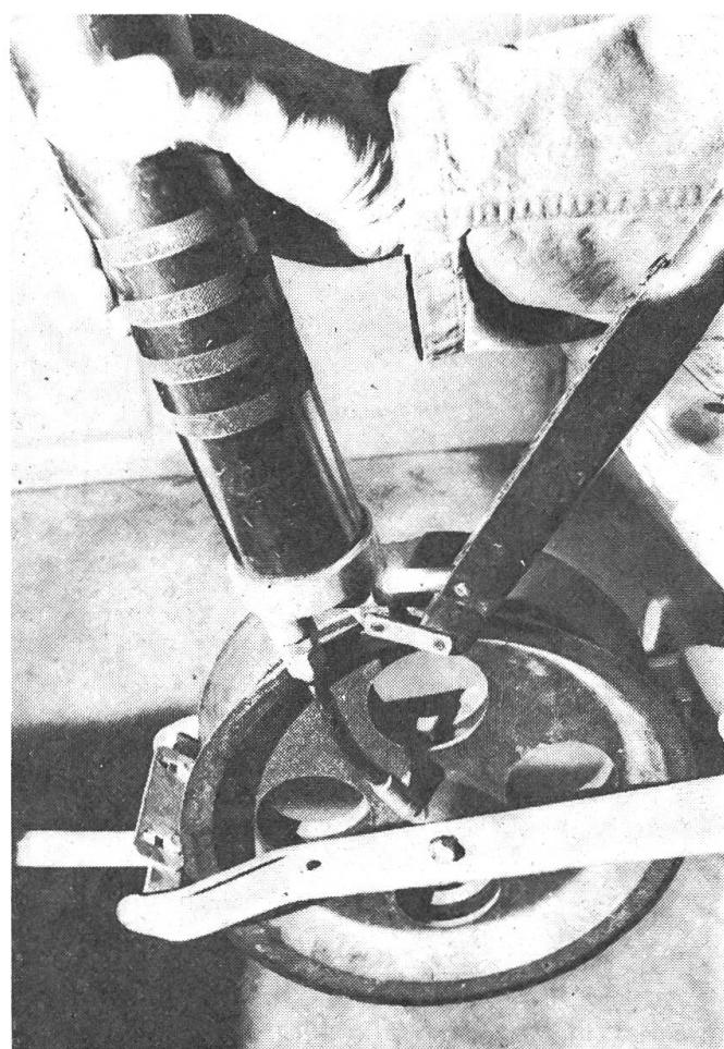
Während die Säorgane der Einzelkorndrille nur knapp eingefettet werden, sollten die Laufräder gründlich abgeschmiert werden.
