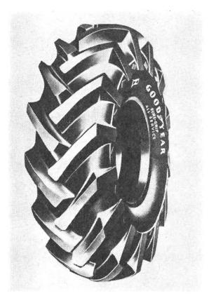
«Sure-Grip, All Service» der Triebachsreifen für Ackerschlepper.
