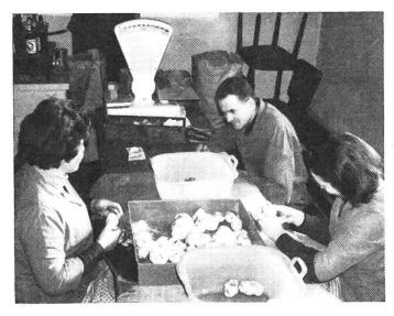
Abb. 10b: Die noch sichtbaren Beschädigungen werden anschliessend gezählt und zur Klassierung mit einem Schälmesser auf ihre Tiefe untersucht.
