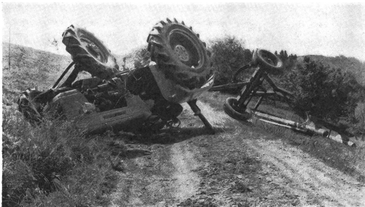
Das Befahren von aufgeweichtem Gelände hat dem Lenker des oben abgebildeten Allrad-Traktors mit unbeladenem Anhänger das Leben gekostet. Das Fahrzeug geriet auf einer Bodenwelle mit ca. 35 % Steigung ins Gleiten und überschlug sich beim Einmünden in die Bergstrasse. BUL
