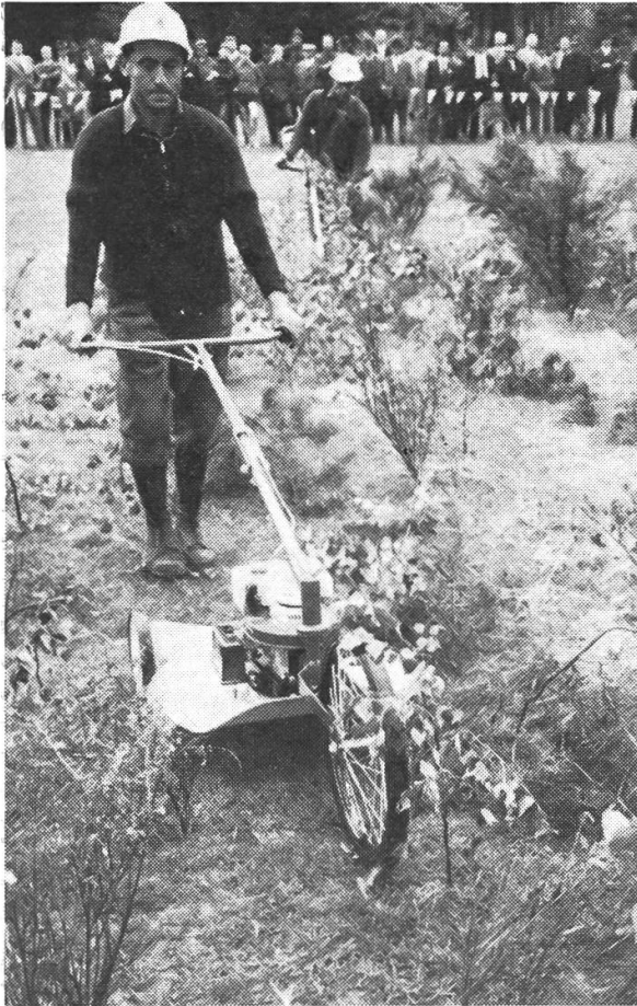
Abb. 5: Dieses selbstfahrende Gerät hat ebenfalls eine Messerscheibe zum Freischneiden von Kulturen. Es soll 0,40-0,50 ha je Mann und Tag schaffen.
