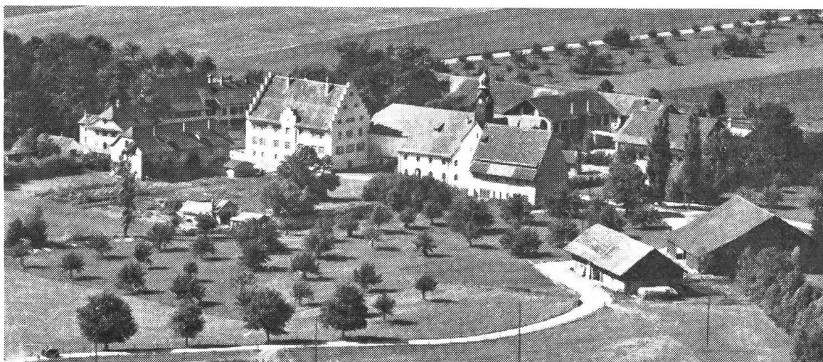
Ansicht des bisherigen Gebäudekomplexes in Tänikon
